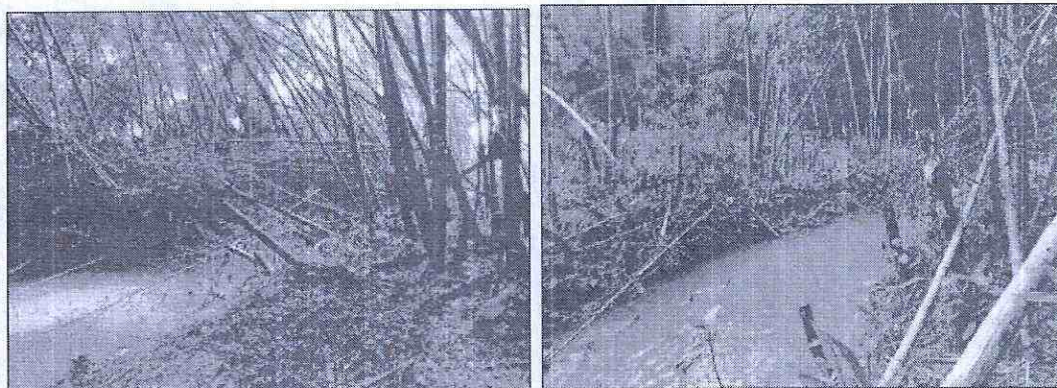
Fotografía 4 - 9. Características del área afectada mediante tala de zona de protección quebrada Calamo, barrio Guaduales, municipio de Pitalito Huila.
