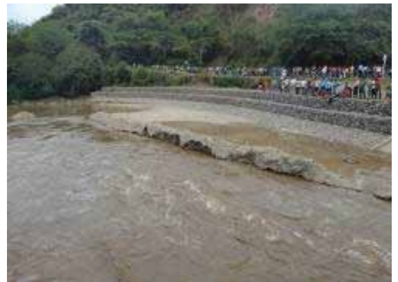
Conformación de gaviones y colchagaviones en el cauce de la Quebrada La Viciosa - Municipio de Guadalupe.
