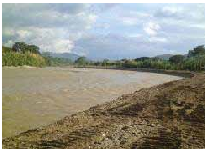
Conformación de dique en el Río Suaza (Municipio de Suaza).
