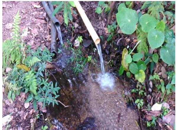
*Fotos 5 y 6. Tubería para posibilitar la continuidad del agua hacia el canal.*
