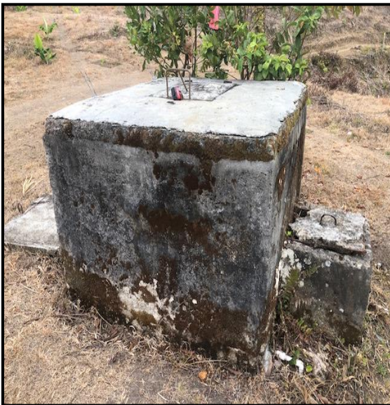
Fotografías 1 y 2: Obra hidráulica tanque almacenamiento y distribución
