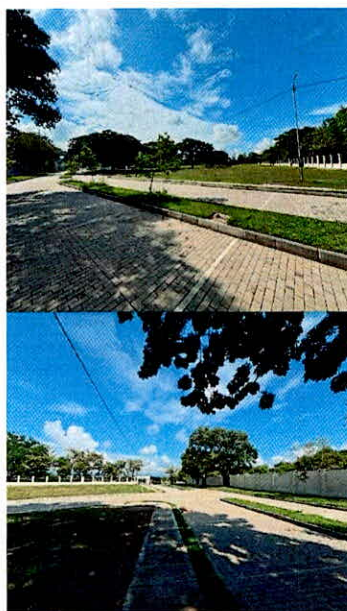
Registros fotográficos No. 1 y 2: vista de las zonas donde se implementará el sistema de reúso del agua.
