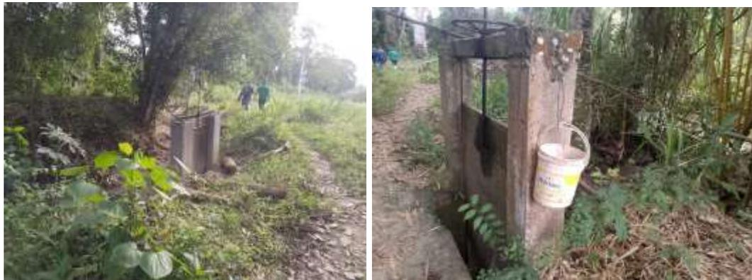
**Fotografía 7 y 8.** Compuertas de control de caudal y desarenador del canal Lisboa.
