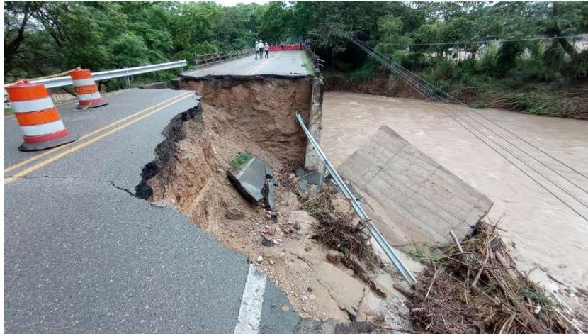
Municipio de Rivera, pérdida de parte del puente que atraviesa la quebrada Arenoso, producto de socavación lateral y de fondo.
