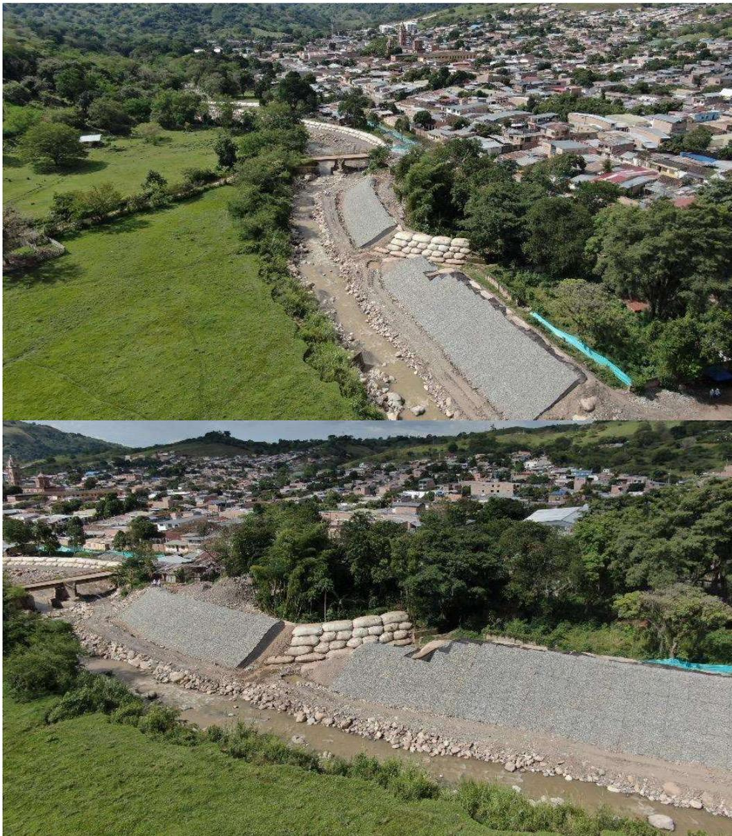
Construcción de dique o muro de protección con megabolsas, canalización del río Timaná, municipio de Timaná.
