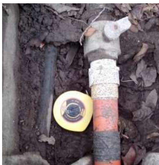
Fotografía 5. Cajilla con válvula de control y Fotografía 6. Tuberías de 2" y 3".
