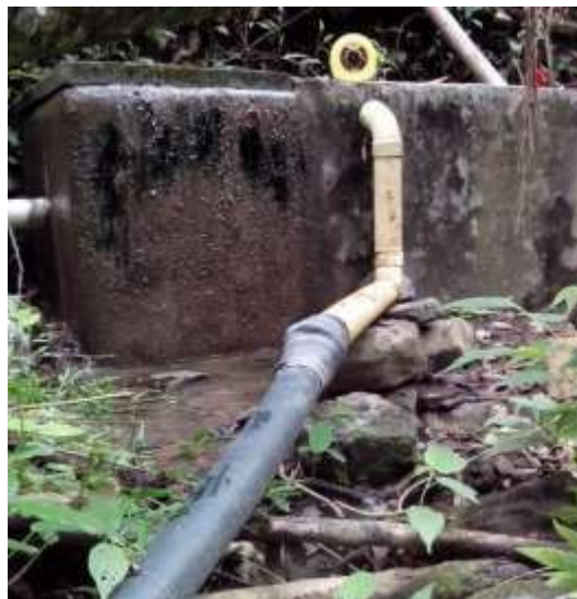
Fotografía 13. Salida de tubería blanca de 3" y Fotografía 14. Tubería de restitución de sobrantes a la cual se le ha instalado una manguera negra de 3".
