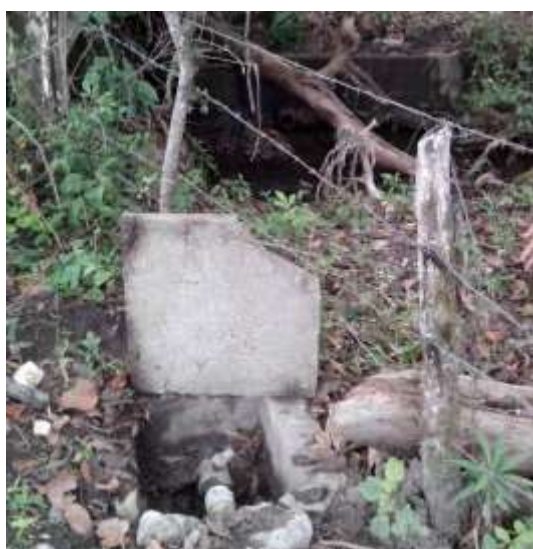
Fotografía 5. Cajilla con válvula de control y Fotografía 6. Tuberías de 2" y 3".
