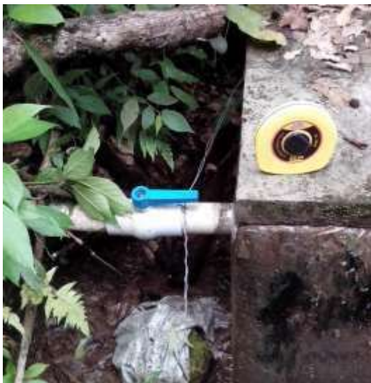
Fotografía 13. Salida de tubería blanca de 3" y Fotografía 14. Tubería de restitución de sobrantes a la cual se le ha instalado una manguera negra de 3".
