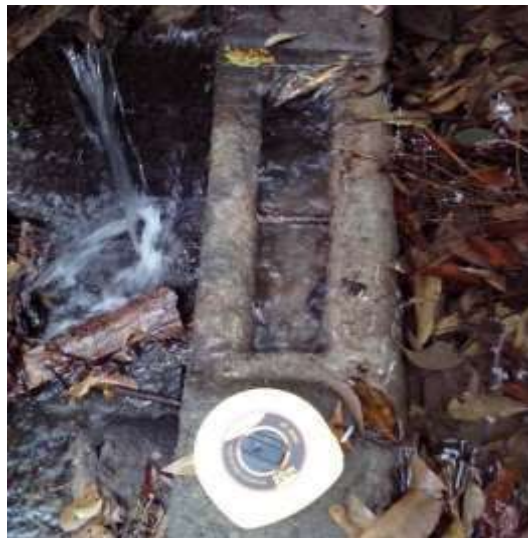
Fotografía 3. Nicho mediante el cual se efectúa la captación y Fotografía 4. Tanque de captación.
