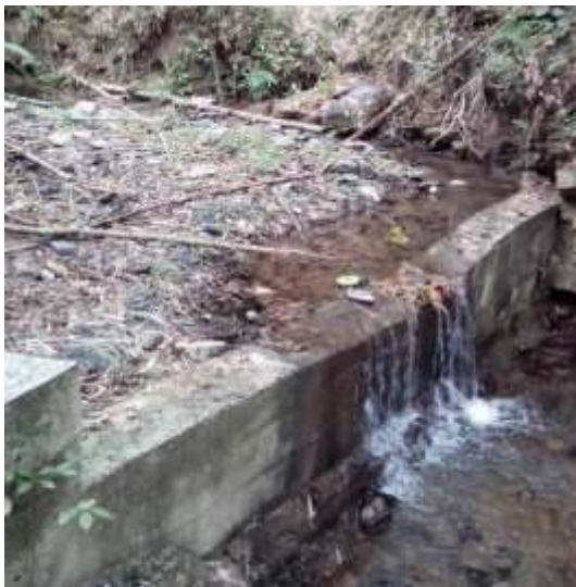
Fotografía 9. Muro de captación y Fotografía 10. Vista posterior del muro de captación.
