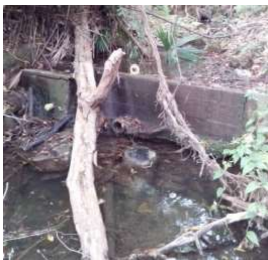
Fotografía 1. Muro de hormigón que intercepta el cauce de la quebrada San Joaquín y Fotografía 2. Vista tras el muro de captación
