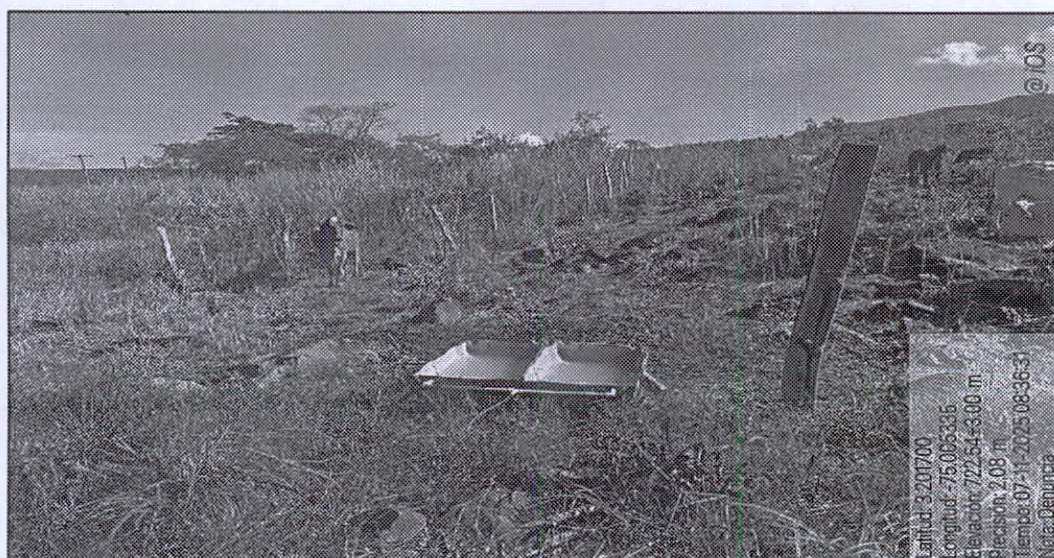
Fotografía No. 9. Tercera conexión de abastecimiento desde el canal de riego, por medio de una manguera de un cuarto de pulgada. Fuente: Propia.
