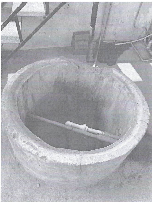
Registro fotográfico No. 1. Aljibe objeto a concesionar a cargo del señor Dairon Vargas, ubicado en el establecimiento Autolavado Servi Wash Neiva, sobre la Carrera 15 No. 1-27, municipio de Neiva (Huila).
