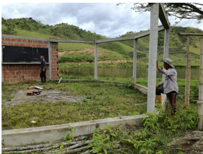
Imagen 6. Infraestructura junto al ecosistema de humedal
