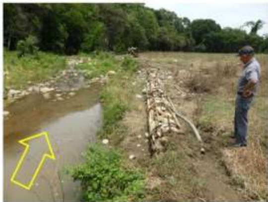
Quebrada La Nutria, en el sector Interlagos. Nótese una obra en piedra construida para proteger la orilla.
