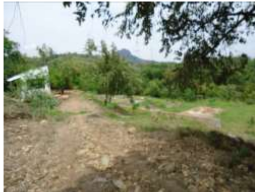
PTAR del municipio de Palermo
