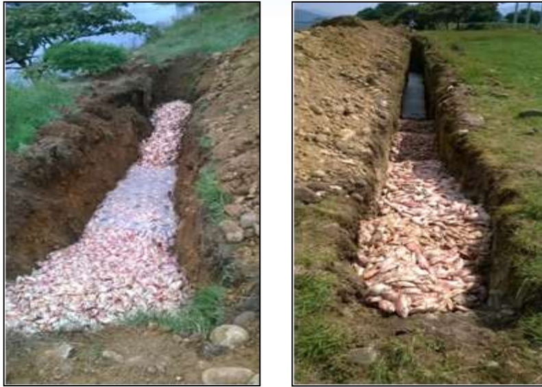
Evidencia de la inadecuada disposición de mortalidad: enterramiento.
