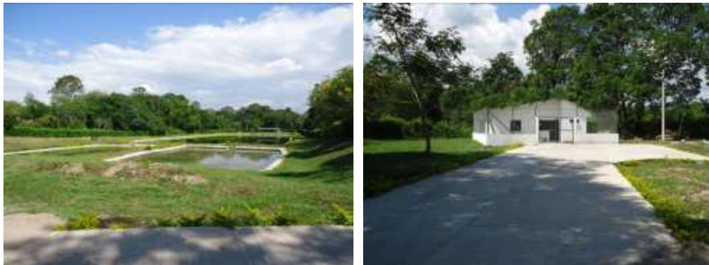
PTAR del municipio de Agrado
