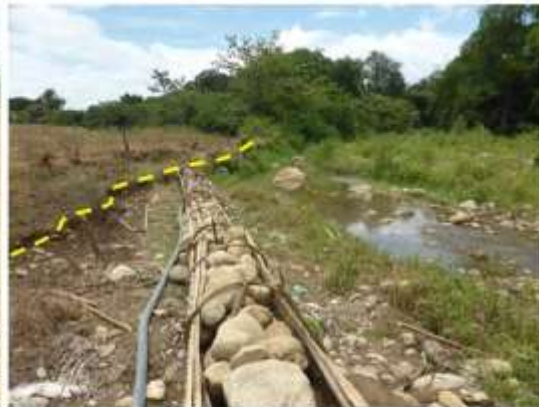
Quebrada La Nutria, en el sector Interlagos. Nótese una obra en piedra construida para proteger la orilla.
