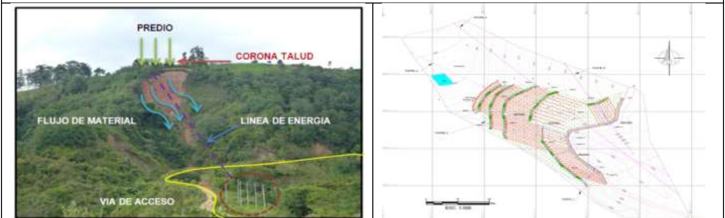
Figura 6. Falla geológica en la vereda Palestina, que amenaza en la parte alta algunas viviendas y aporta gran cantidad de sedimentos al río.
