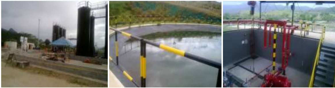
Estado en la planta de cargadero y mezcla de Rioloro, que no está en operación.
