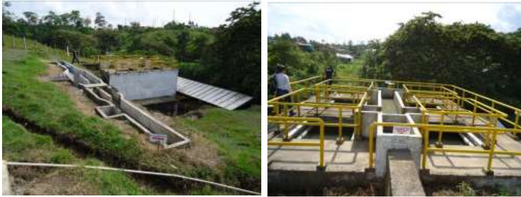
PTAR del municipio de Saladoblanco
