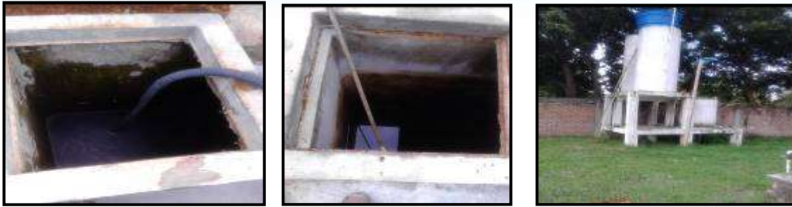
Fotos xx. Tanques sedimentadores de la PBA de La Plata.
