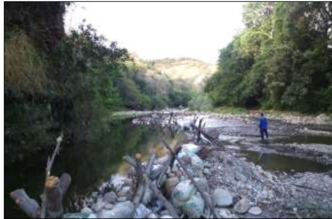
Dique artesanal sobre el cauce del Río las Ceibas ocasionando la desviación del agua hacia los canales.
