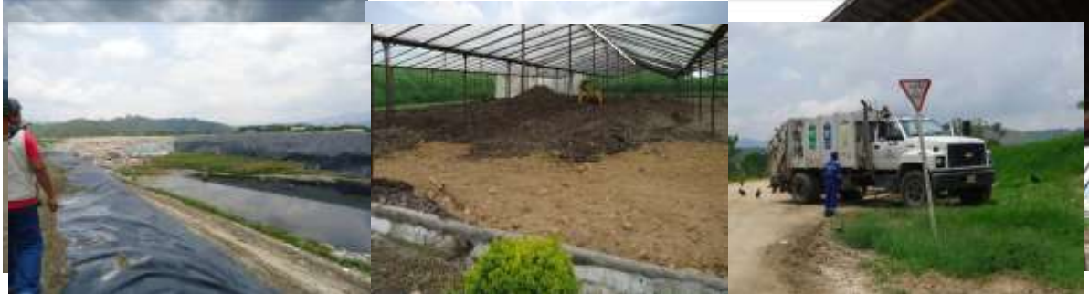
Estado actual Planta Biorgánicos del Sur.
