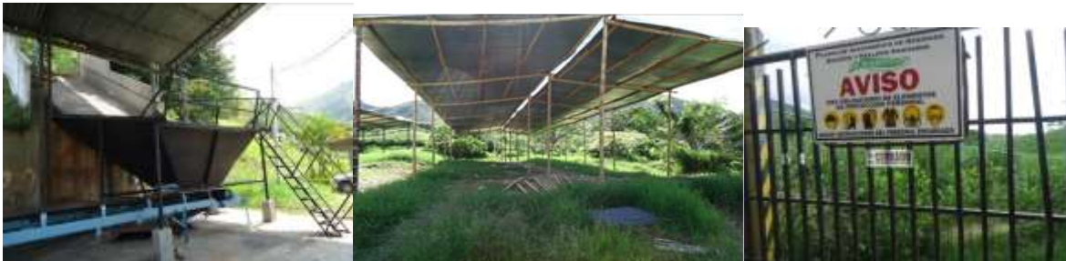
Estado actual Planta Biorgánicos del Centro.
