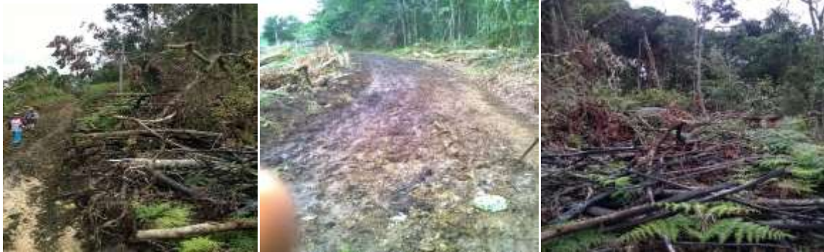
Tala de especies forestales de roble para ampliación de caminos de herradura con maquinaria pesada.
