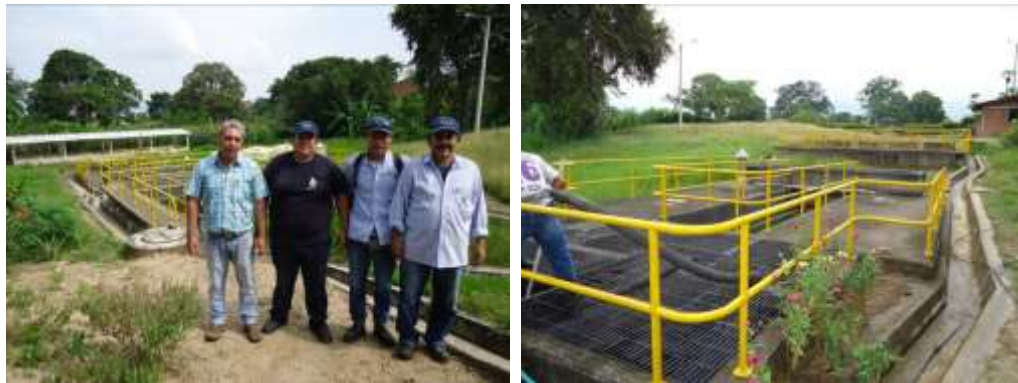
PTAR del municipio de Campoalegre
