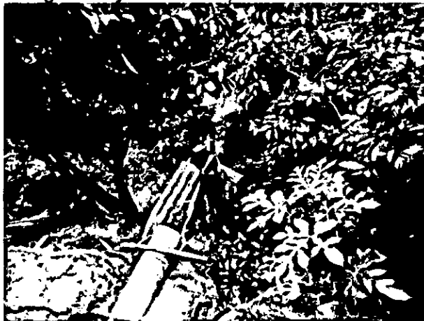
Fotografía 3 y 4. Conducción de las aguas residuales domesticas de la cocina, ducha, lavadero hacia el punto de descarga sin tratamiento previo.
