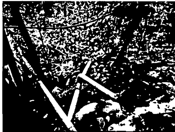
Fotografía 3 y 4. Conducción de las aguas residuales domesticas de la cocina, ducha, lavadero hacia el punto de descarga sin tratamiento previo.
