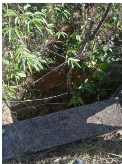
Figura 10. Box culvert de aguas intermitentes.
