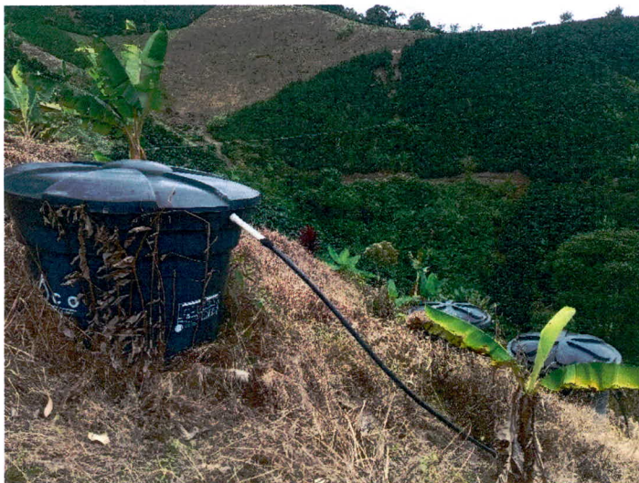
Fotografías N° 14,15 Tanques de almacenamiento y distribución – Red de conducción en PVC
