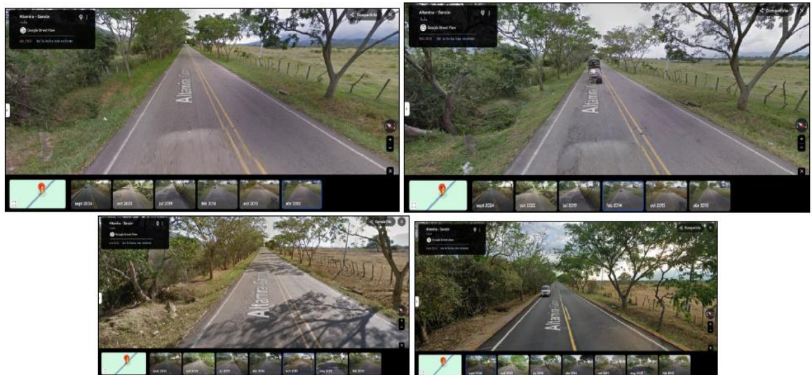
Figura No. 5 panorámica obra hidráulica UF4-83, Vereda Llanos de la Virgen, Municipio Altamira – Huila
