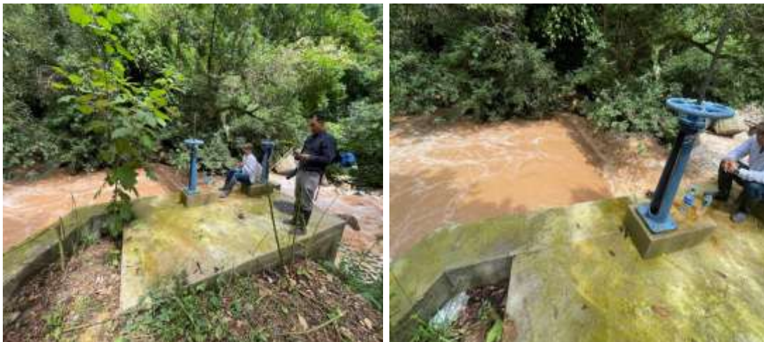
Foto 1 y 2. Estructura de cámara de recolección y distribución.
