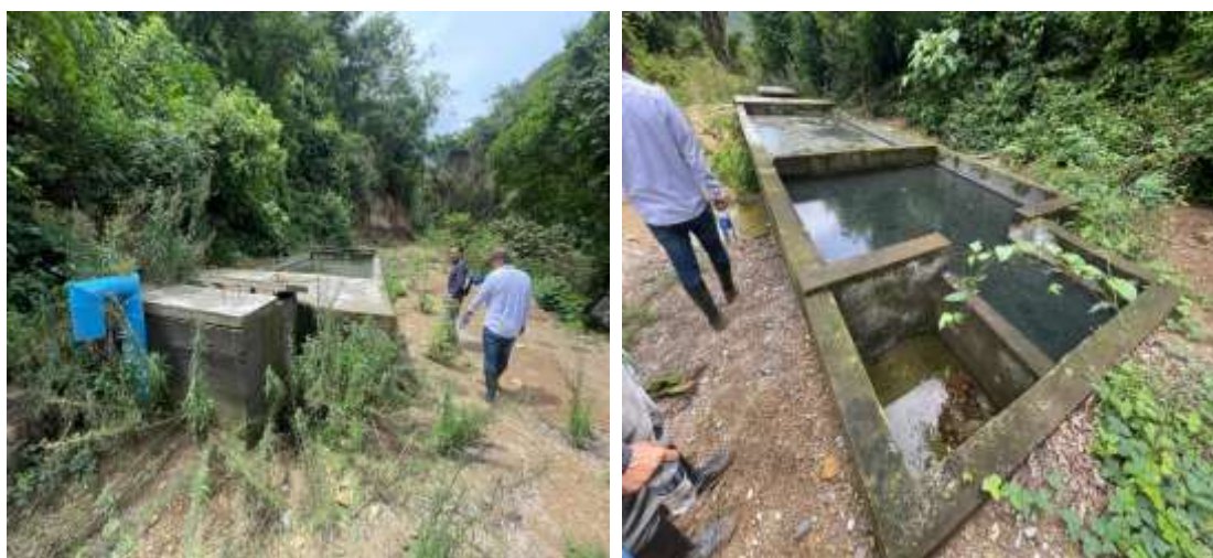
Foto 3 y 4. Estructura tanque desarenador.
