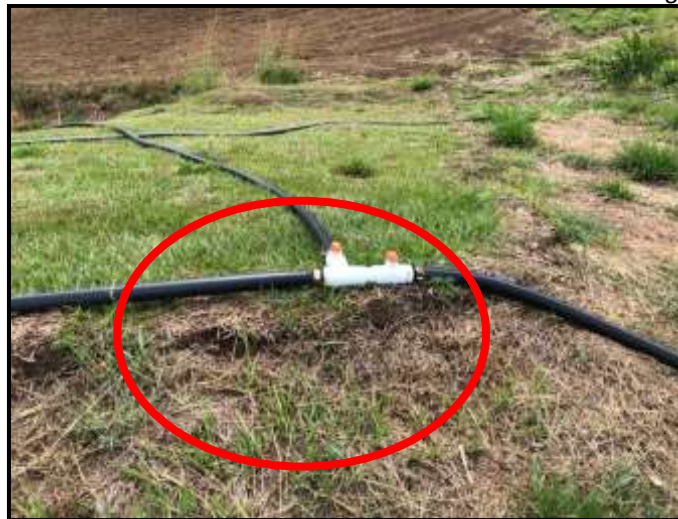
Fotografía 5. Obra hidráulica control caudal-vereda Llano de la virgen-Altamira
