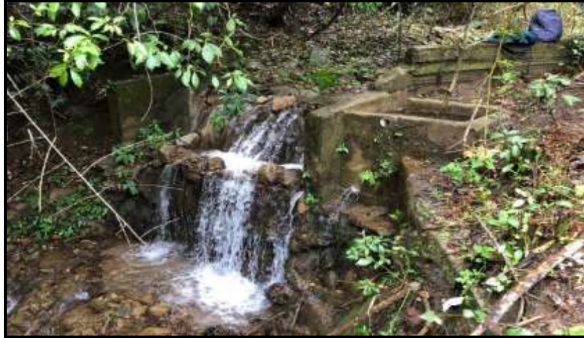
Fotografía 2. Punto de captación-sector las mercedes-Garzón-Huila
