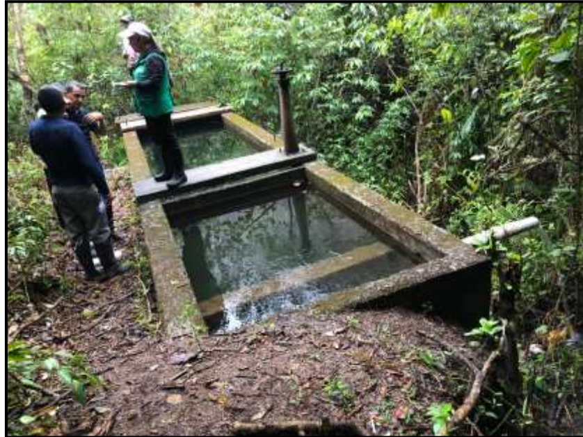
Fotografía 3. Desarenador-sector las mercedes-Garzón-Huila
