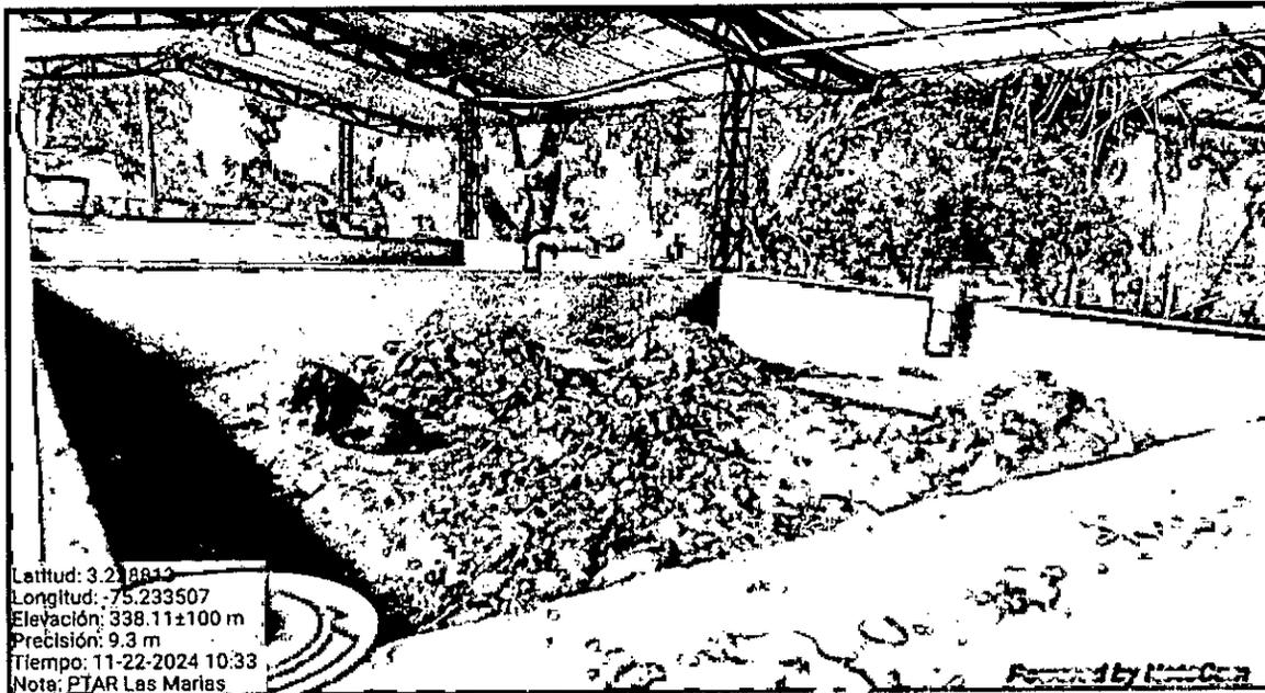
Fotos 11 y 12: Evidencia fotográfica de los lechos de secado instalados en la planta de tratamiento de aguas residuales domésticas – PTAR Las Marías del municipio de Aipe
