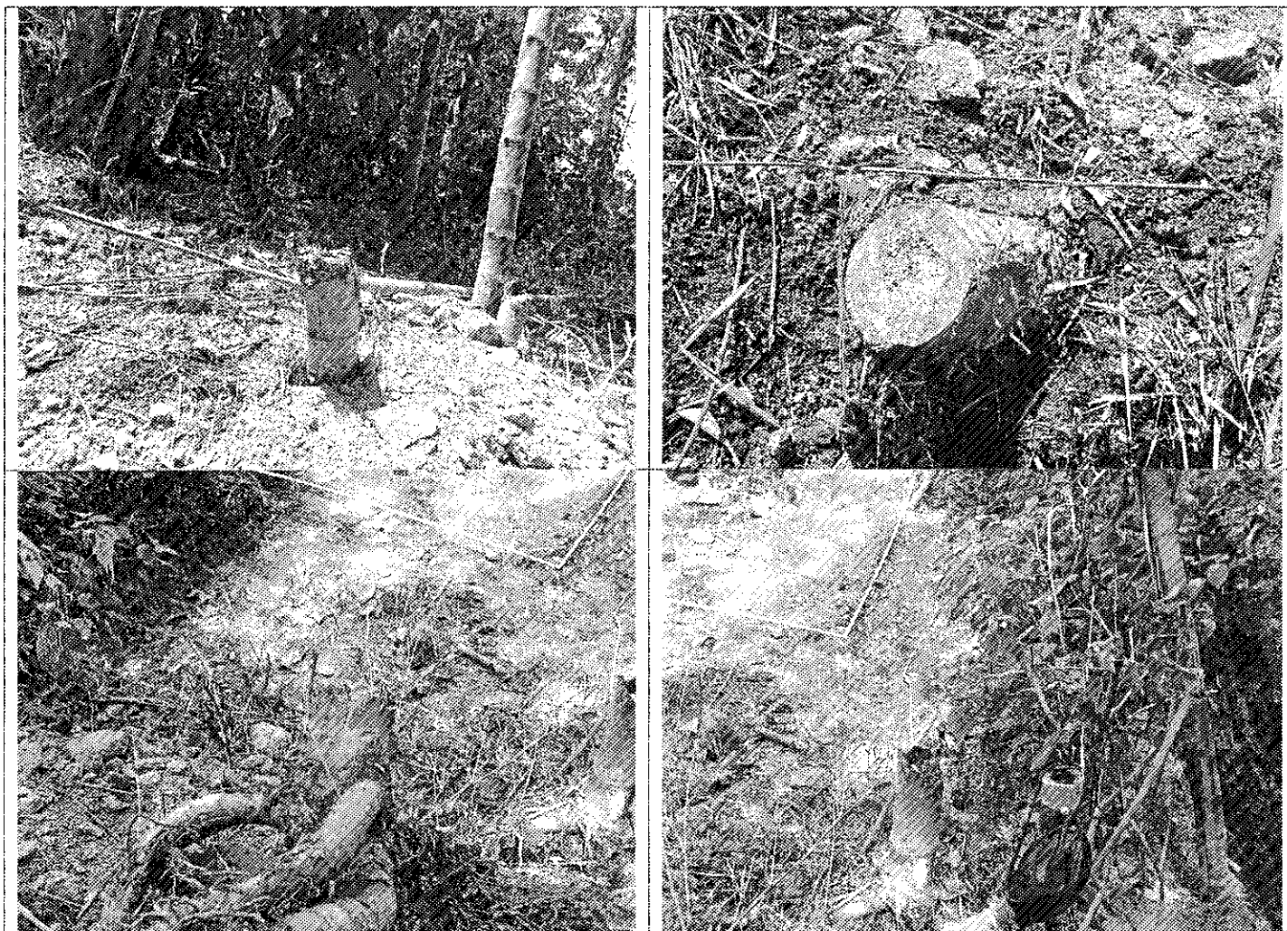
Fotografía 1-4- tocones de guadua y raíces producto de la realización del alcantarillado.
