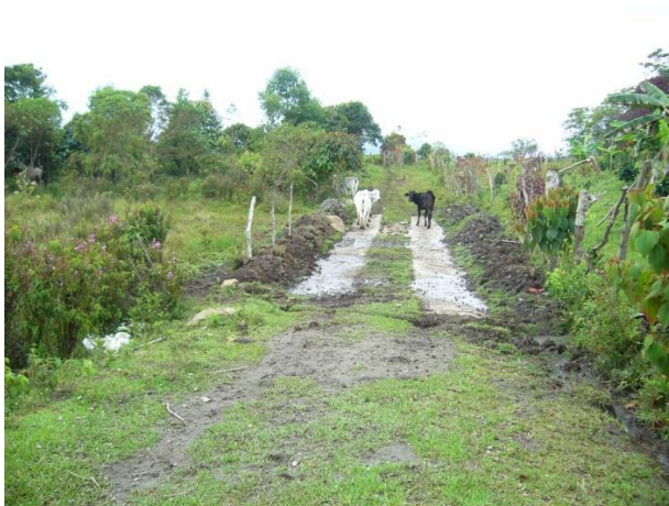
Imagen 7. Infraestructura vial que afecta el ecosistema de humedal
