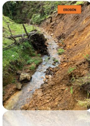
Imagen 1. Proceso erosivo sobre el cauce principal de la quebrada La Chorrera en el Tramo 0.
