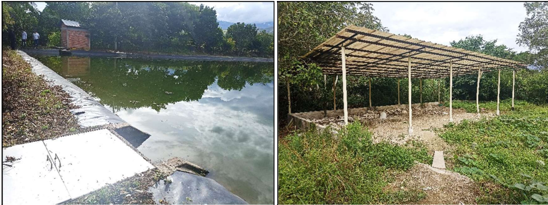
PTAR Gigante, retiro de exceso de lodos, cerramiento, reposición de tapas por acero inoxidable, y cubierta de lecho de secado de lodos.
