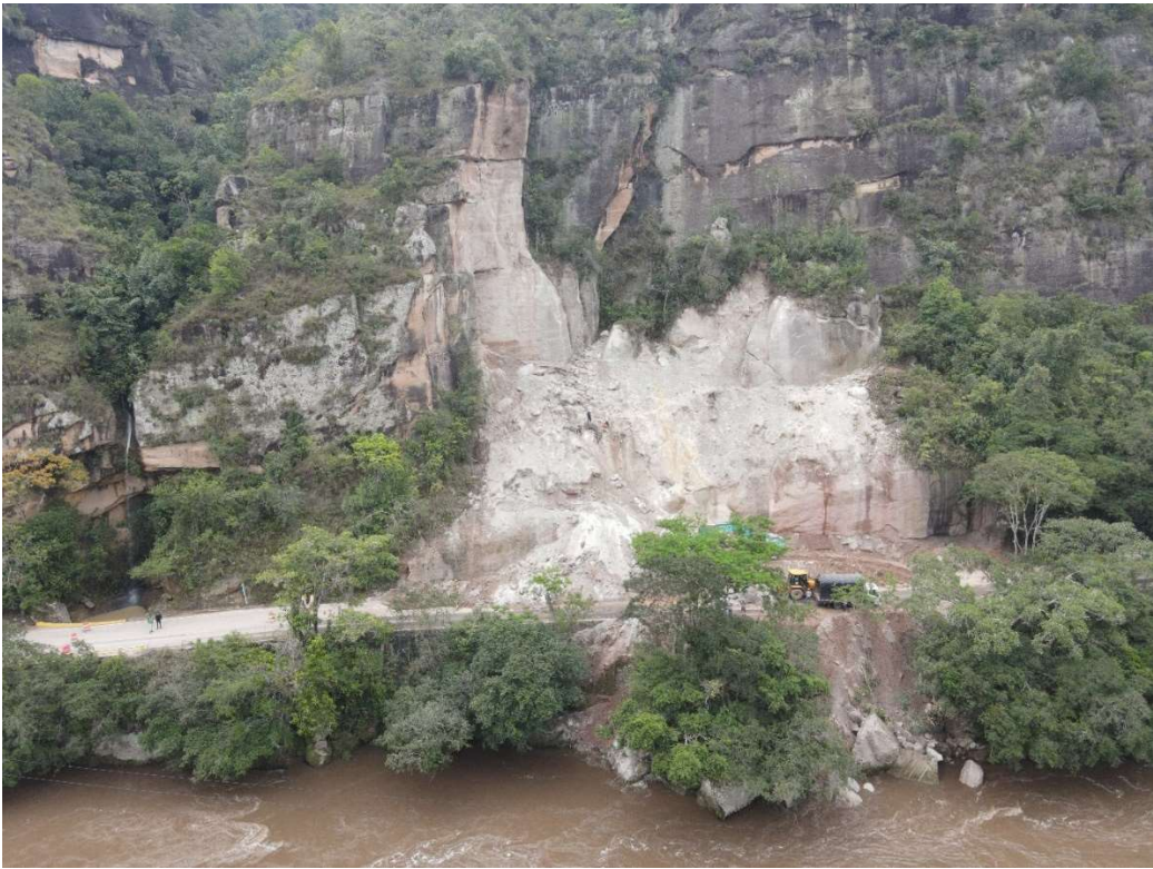
Municipio de Timaná, sector Pericongo, Ruta Nacional 45-04 Tramo PR 28+600
