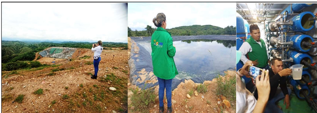
Relleno Sanitario Los Ángeles – Celda de disposición actual, Tratamiento y Piscina de lixiviados
