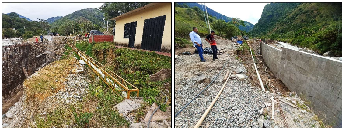
PTAR 1 Santa María, prolongación del emisario final, y PTAR 2 construcción de obras de Gestión del Riesgo para estabilizar el talud
