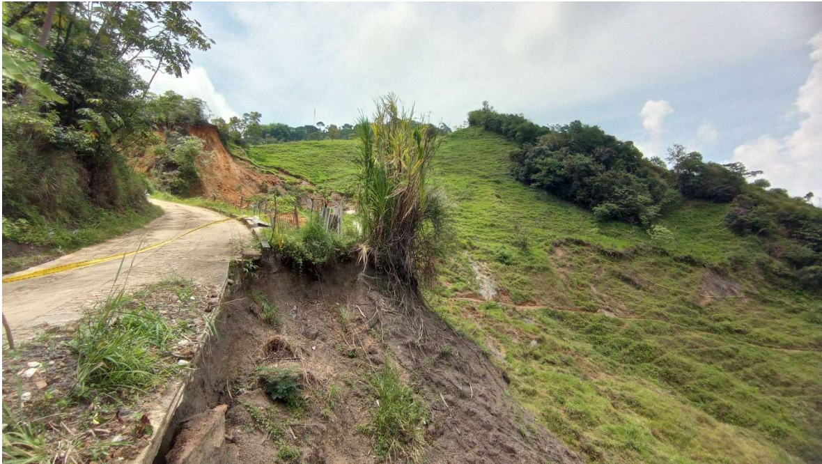
Municipio de Tello, Movimiento en masa en la parte alta de la vereda El Cedral
