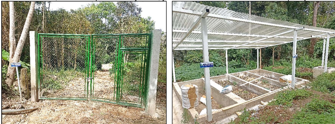
PTAR San Agustín, terminó su inversión en cerramiento y nuevo lecho de secado de lodos, hace un manejo eficiente de gases
