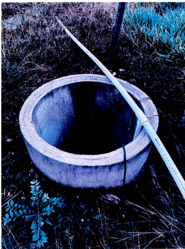
Registro fotográfico No. 2. Aljibe objeto a concesionar, ubicado en el predio "El Bombeo - LT 4", vereda Juncal del municipio de Rivera (Huila). Fuente: Funcionario CAM.
