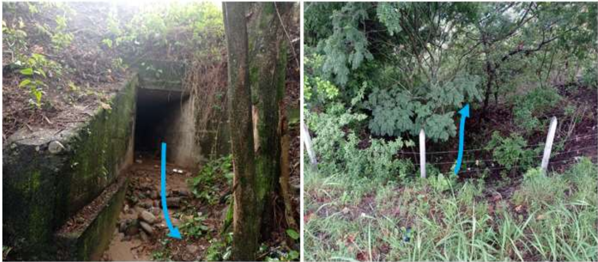
Fotografía 4 Y 5. Obra hidráulica UF2-ID- 367 ubicada en la abscisa de diseño K43+091 (descole).
