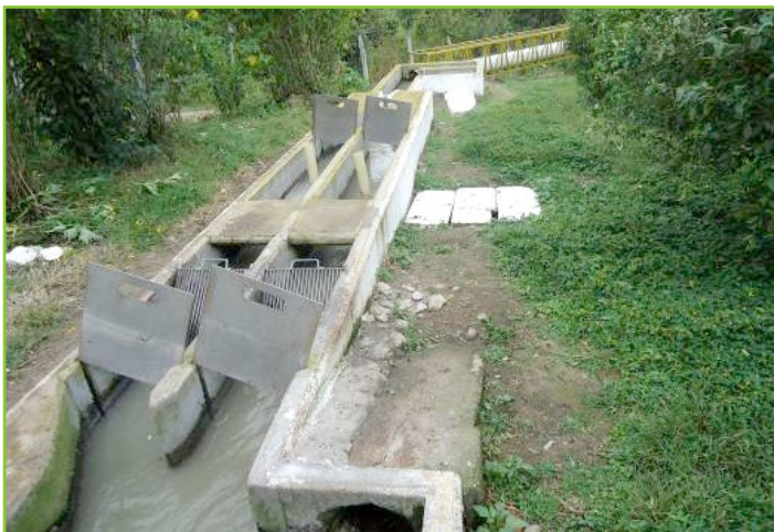
PTAR del municipio de Altamira
