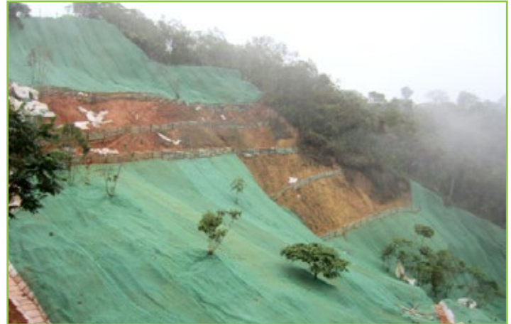
Obras de bioingeniería en proceso erosivo Ginebra (Vereda Primavera), noviembre 2016
