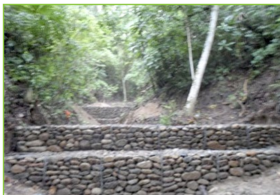
Obras de control de Inundación Quebrada El Zapatero La Plata y Obra de Control Hidráulico – reducción del riesgo Quebrada El Salado Rivera
