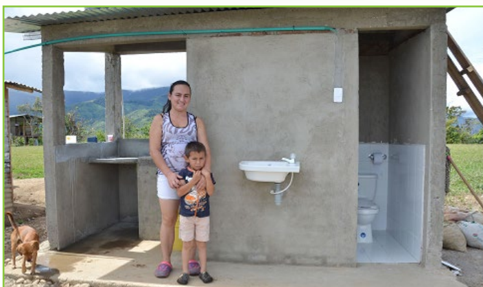
Batería Sanitaria - vereda Primavera
