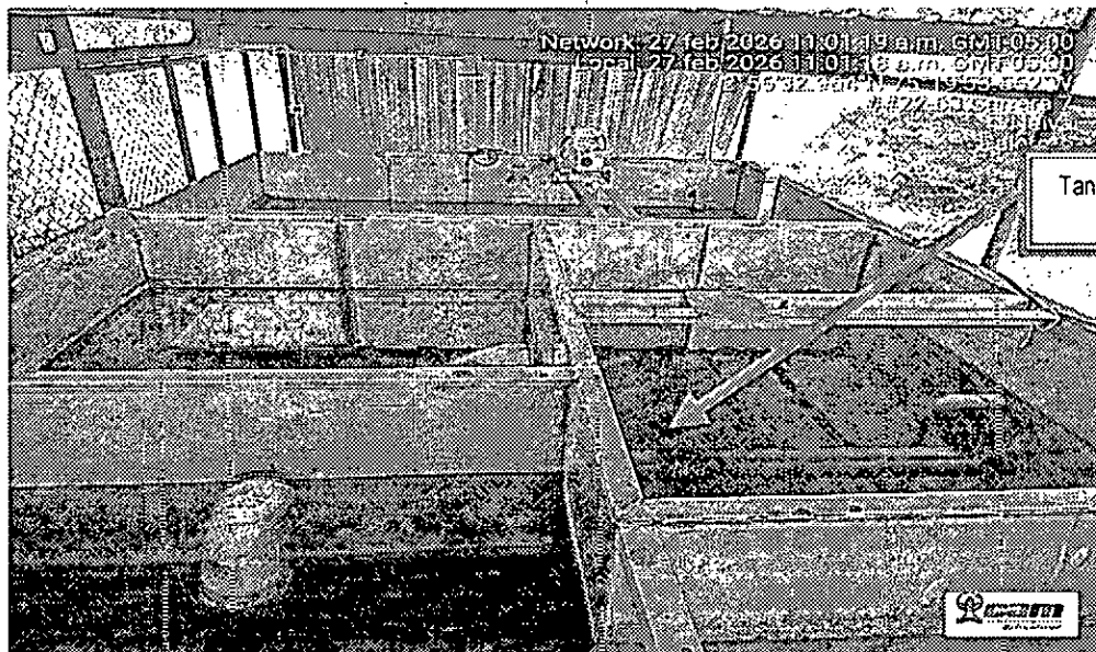
Foto 6: Evidencia fotográfica del tanque compacto que conforma el sistema de tratamiento de aguas residuales domésticas – ARD construido en el Condominio Campestre San Sebastián.
