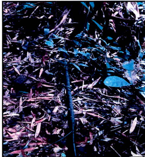
Fotografiar No. 3: Línea de conducción manguera de polietileno 1” vereda Uvital-Pital-Huila
