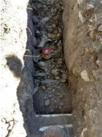
Se realizó la instalación de la red de suministro de agua desde el pozo profundo y acometida hidráulica de la red de acueducto en la sede principal de la CAM ubicada en la Carrera 1 No. 60 – 79 de Neiva.
