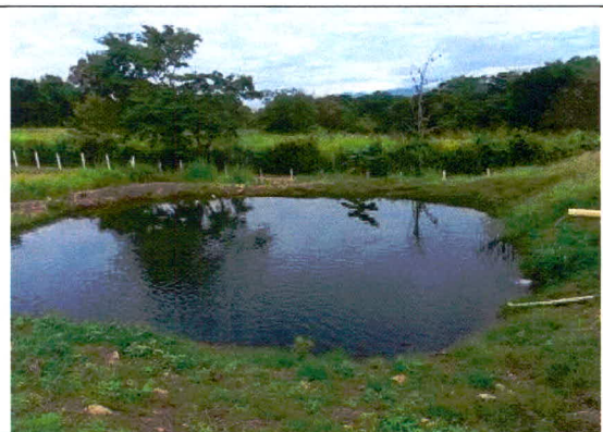
Fotografía No. 9. Laguna de oxidación (9)
