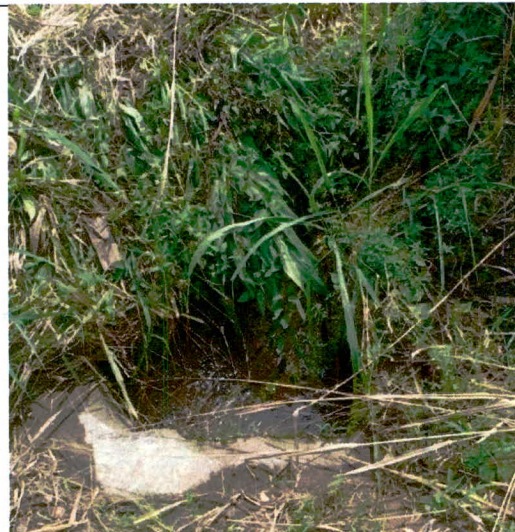
Fotografía No.19. Segunda Derivación Canal Molino Coordenadas: X=829744 Y= 739064
