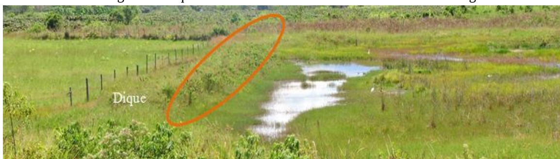
Imagen 14. Dique construido al costado norte del humedal Marengo
