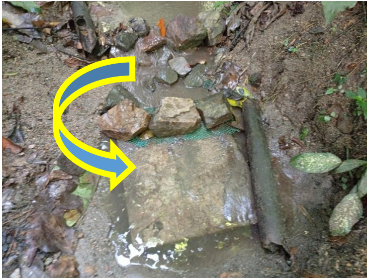
Fotografías 4 y 5 Salida de cajilla y red de conducción cerrada
