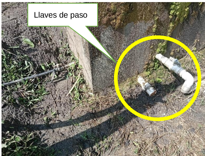
Fotografías N° 11,12 Red de conducción con llaves de paso y riego por goteo
