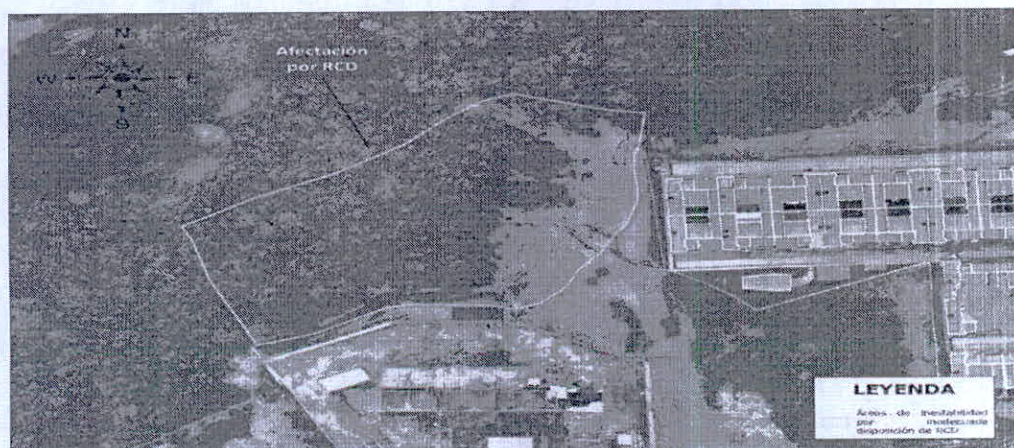
Imagen 13. Zona delimitada como posible afectación por la inadecuada disposición de RCD en la ladera. Fuente: Anexo 2.
