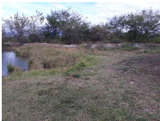
Figura 28. Dique construido con estériles de construcción en el costado occidental del reservorio
