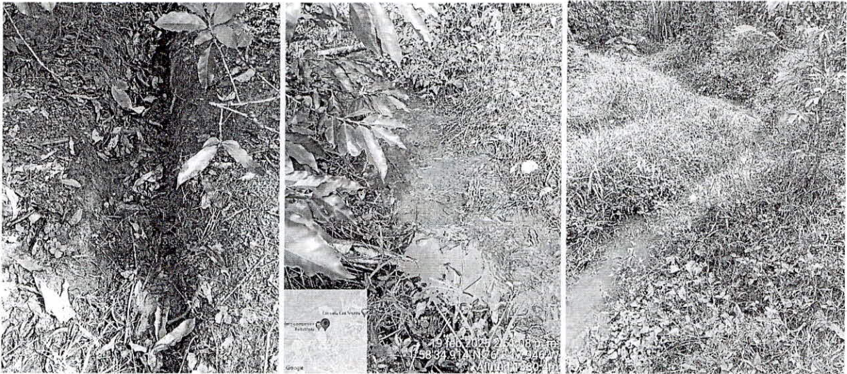
Fotografía No 8, 9 y 10. Descarga y conducción de aguas Residuales domesticas sin tratamiento
