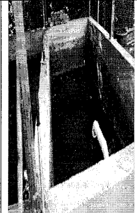
Foto 12. 12/11/19. Lechos de secado de lodos. Sin caracterización de los lodos y disposición final de los mismos.
