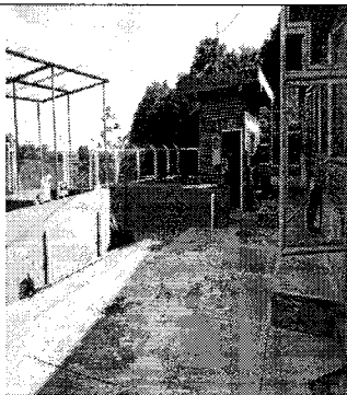
Foto 13.12/11/19. Entrada a la PTAR. Séptima Etapa Cincuentenario. No presenta una valla de identificación de la PTAR
