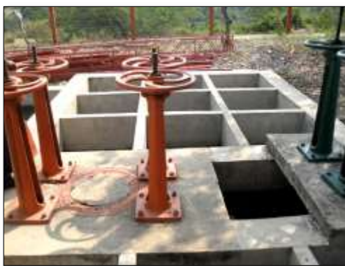
Imagen 4. Compartimiento de floculación - PTAP municipio El Hobo.
