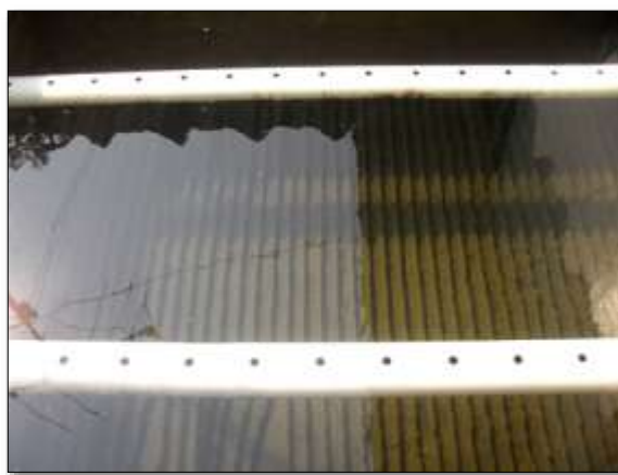
Imagen 5. Compartimiento de sedimentación - PTAP municipio El Hobo.
