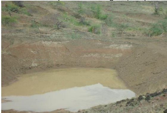
Construcción de 3 Reservorios secuenciales 23,040 m 3 - Establecimiento de 2 parcelas de 2500 m 2 Sábila
