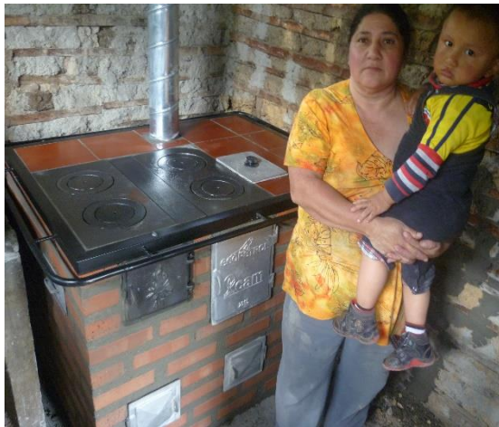
Hornilla ecoeficiente construida en el predio El Progreso de la vereda Las Mercedes del Municipio de Oporapa
