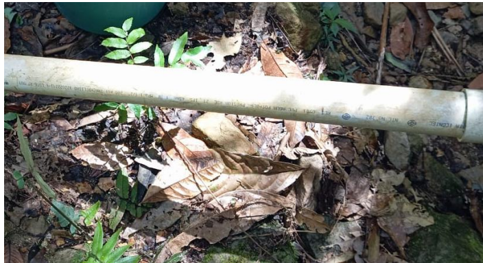
Fotografía No. 5. Manguera de aducción
