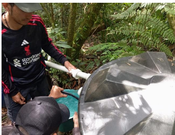
Fotografía No. 16. Aforo caudal método volumétrico
