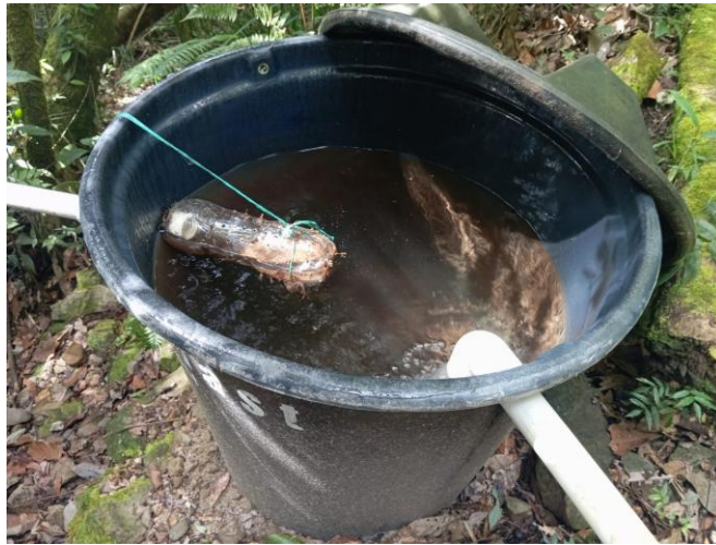
Fotografía No. 6. Tanque desarenador de 250 litros
