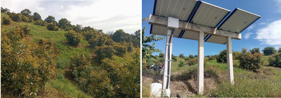
Fotografía No. 14 y 15, cultivo de aguacate y sistema solar para funcionamiento del sistema de bombeo.
