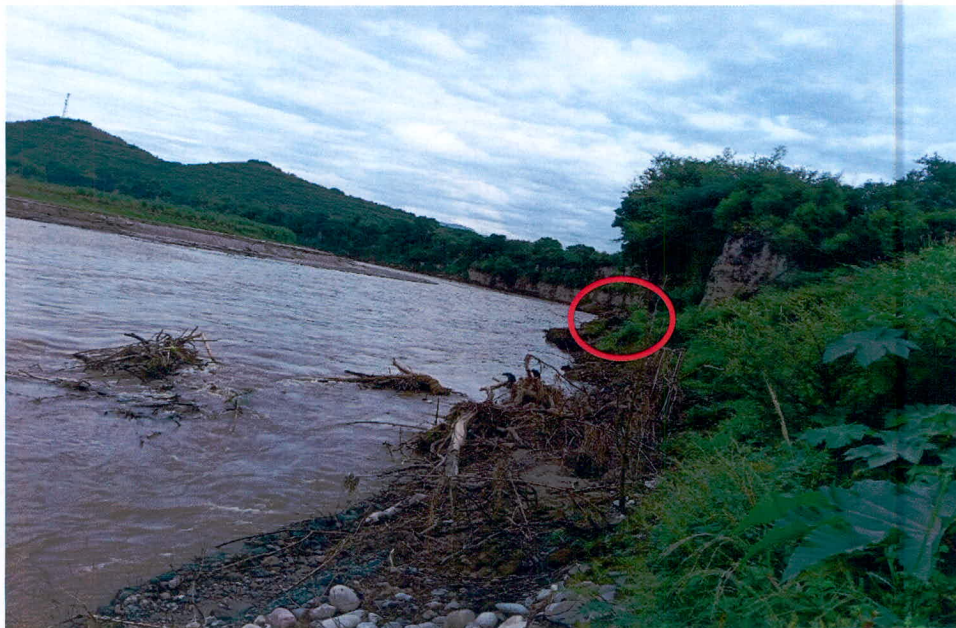
Fotografía 2, Panorámica sitio terminación construcción obra de protección y estabilización de talud mediante geoesteras y geocontenedores Vereda la Cañada, Municipio del Agrado – Huila.
