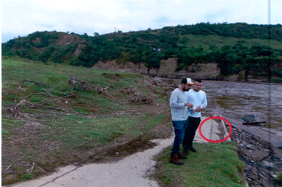
Fotografía 1, Panorámica sitio inicio construcción obra de protección y estabilización de talud mediante geoesteras y geocontenedores Vereda la Cañada, Municipio del Agrado – Huila.
