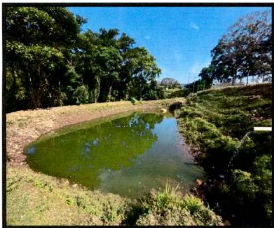
Imagen 8 – Laguna de oxidación
