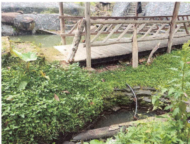
Fotografías 9 ingreso de la manguera a la piscina en concreto.
