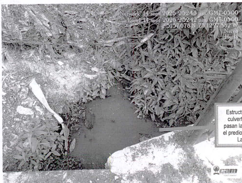
Foto 18 y 19: Evidencia fotográfica del canal en tierra por donde se conducen las aguas residuales domésticas – ARD y de la estructura tipo box culvert por donde pasan las aguas por debajo de la vía de acceso hacia el predio La María.
