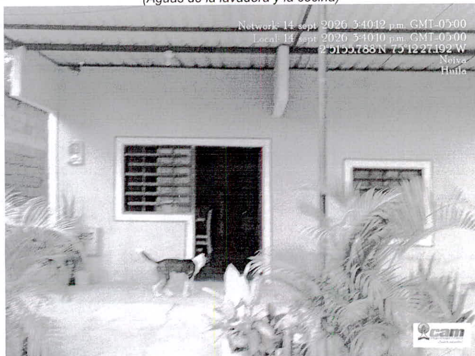
Foto 11: Evidencia fotográfica de los apartamentos que se tienen construidos sobre el predio de la
