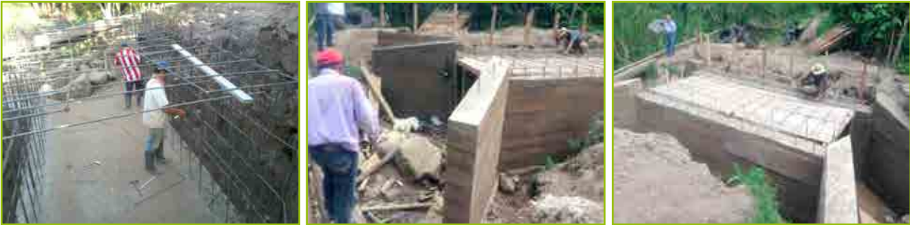
Construcción de un boxculbert con aletas laterales para la estabilización de taludes y encausamiento de las aguas de la quebrada el mono en la vereda Oritoguas del municipio de Salado Blanco.
