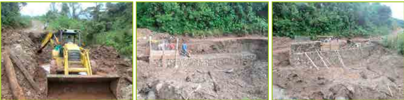
Construcción de muro en gaviones en la vereda san Bartolo en la quebrada la colorada y vereda Bajo Carmen en la quebrada la Aguanegra del municipio de la argentina
