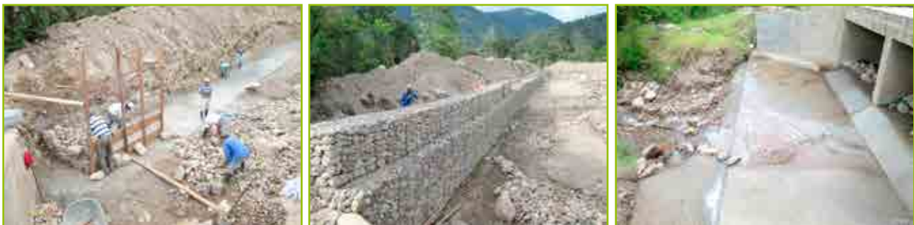
Dragado, construcción de muro en gaviones y disipador de energía en la Quebrada La Pedregosa del municipio de La Argentina
