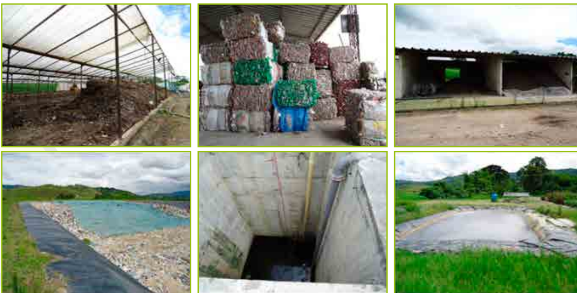
Panorámica de la Planta de Disposición Final Biorgánicos del Sur
