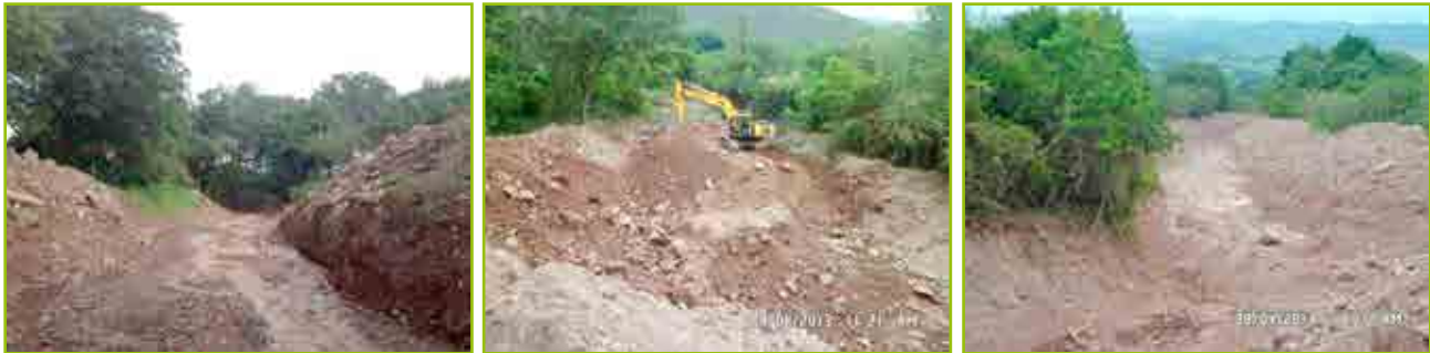
Dragado y rectificación de cauce Quebrada seca municipio del Pital
