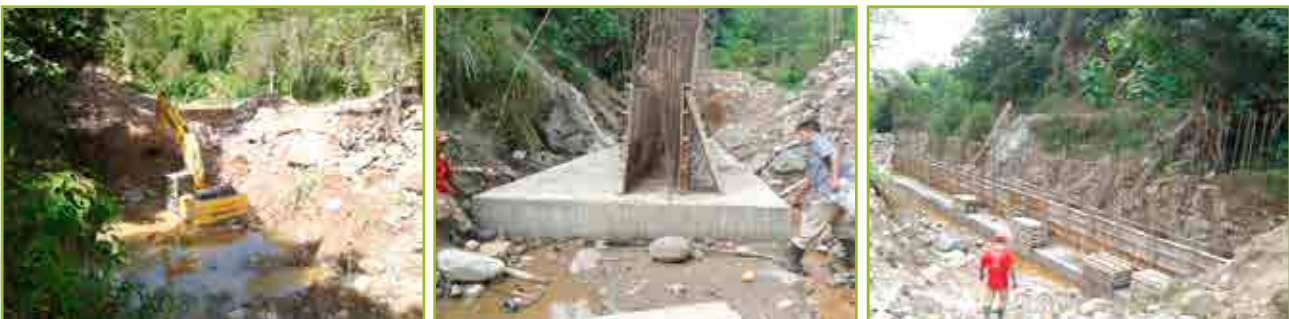
Construcción muro de contención en concreto reforzado en la vereda los cauchos del municipio de San Agustín
