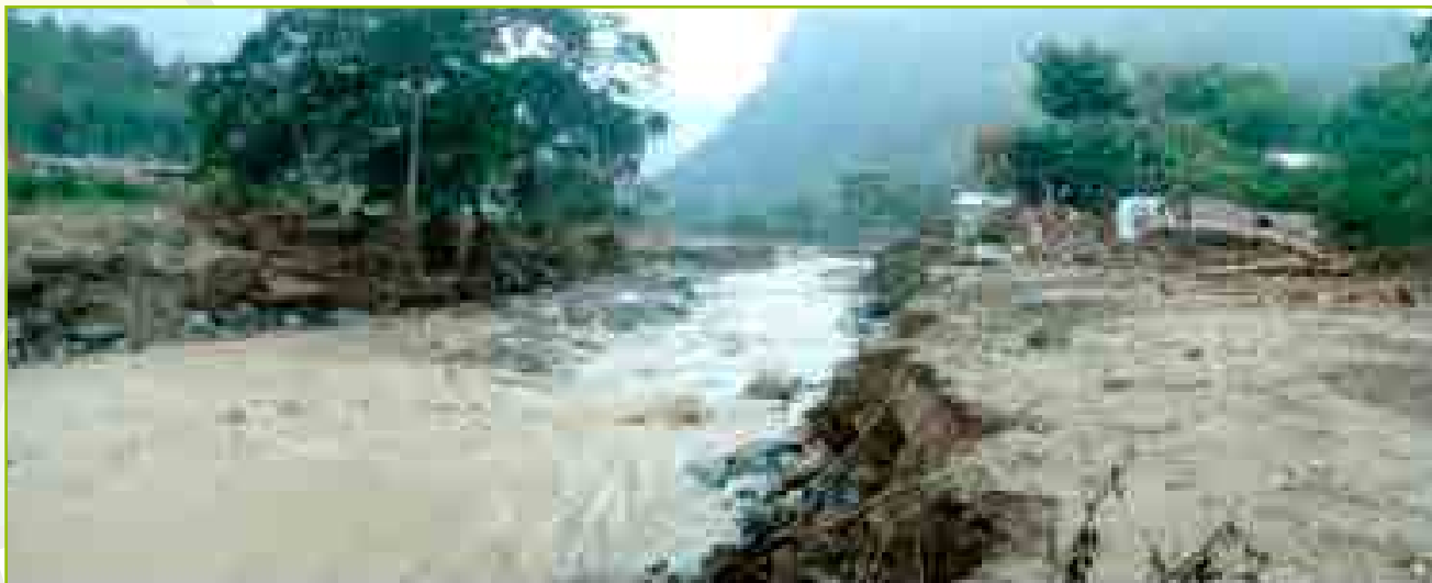
Sector del casco urbano, Municipio de Santa María afectado por la avalancha del río Baché.
