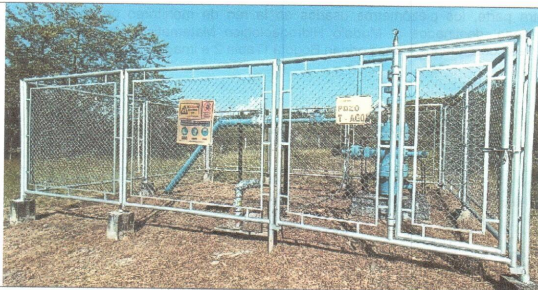
Registro fotográfico 2: Pozo Agua 2 -30/01/2023
