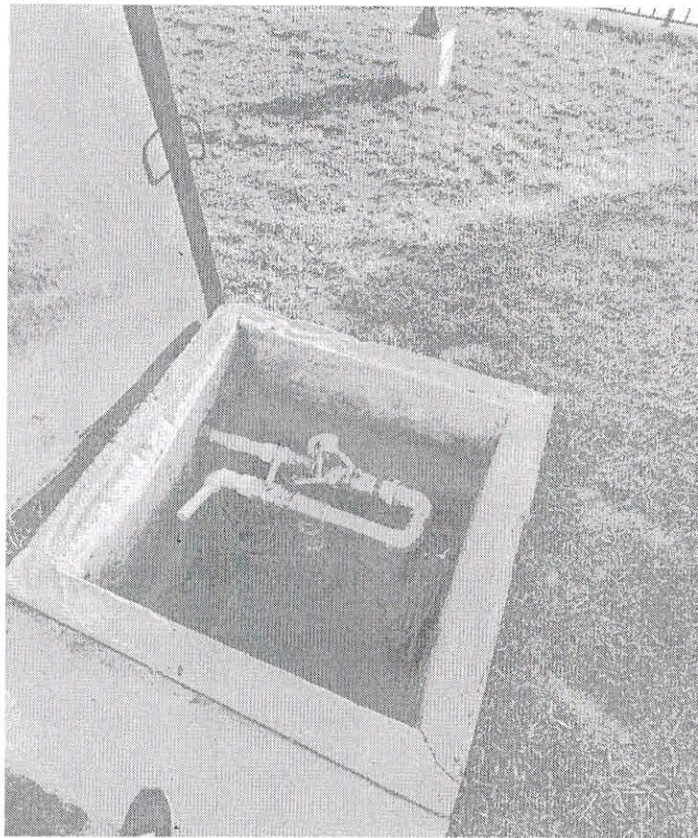
Registro fotográfico 1. Vista del pozo profundo a concesionar
