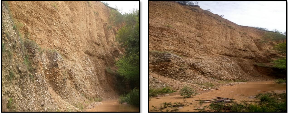
Figura 16. Procesos Erosivos Durante el recorrido del cauce de la Qda. Los Micos. Fuente: FUNDISPROS 2016.
