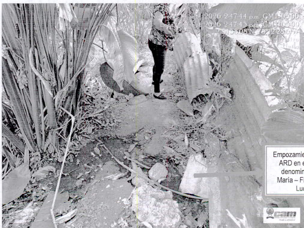
Foto 20 y 21: Evidencia fotográfica de la estructura tipo box culvert por donde pasan las aguas residuales domésticas – ARD hacia el predio denominado La María y a su vez por la finca Villa Lucy en donde son empozadas.
