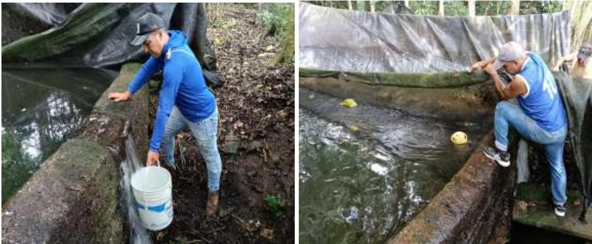
**Fotografía 12 y 13 Aforo volumétrico Nacedero quebrada Lindosa, afluente quebrada Seca.**
