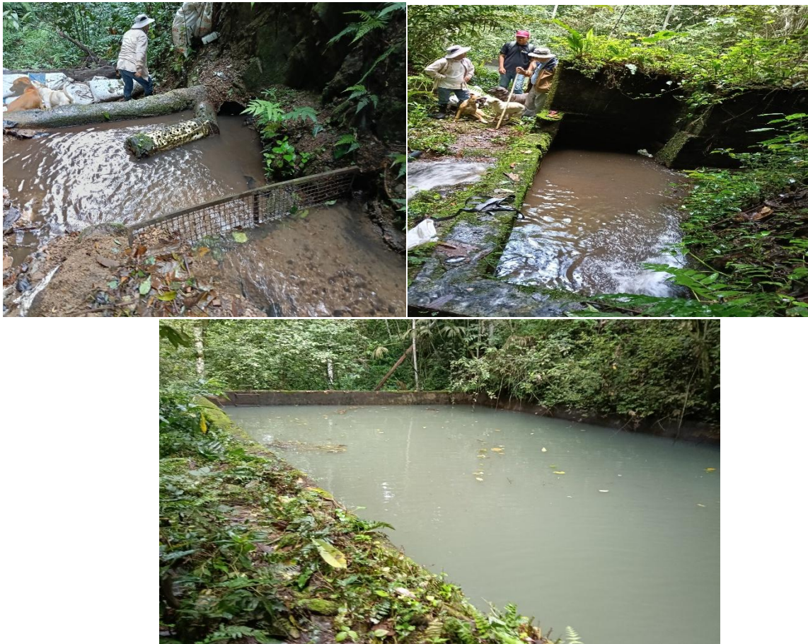
Fotografía 12, 13 y 14 Panorámica Captación quebrada seca, desarenador y tanque de almacenamiento.
